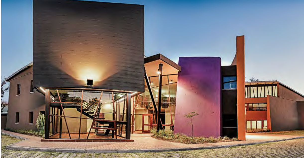
Neubau des Scout-Centers in Nelspruit
